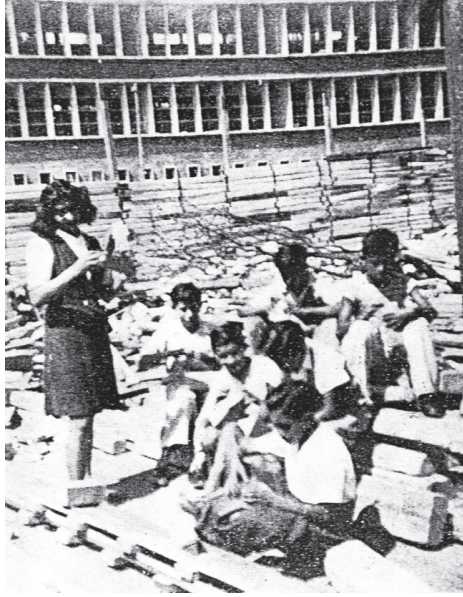
El Departamento de Señoritas atestiguó la demolición del edificio de Santo Tomás y la construcción de la obra de Pani. Archivo BENM.
